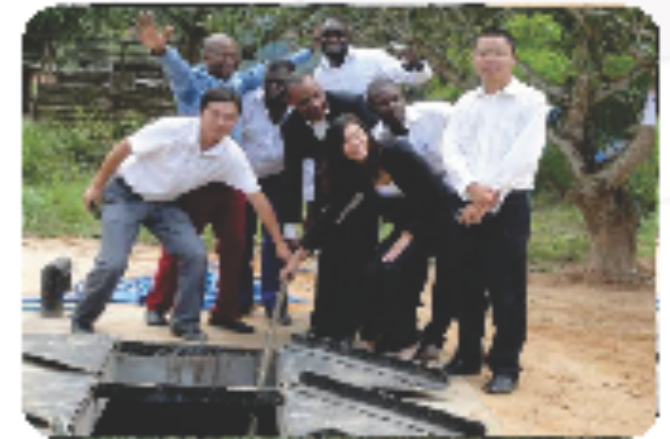
Connexion réussie du câble sous-marin de Congo Télécom sur le site de Pointe Noire avec Huawei et Alcatel.
